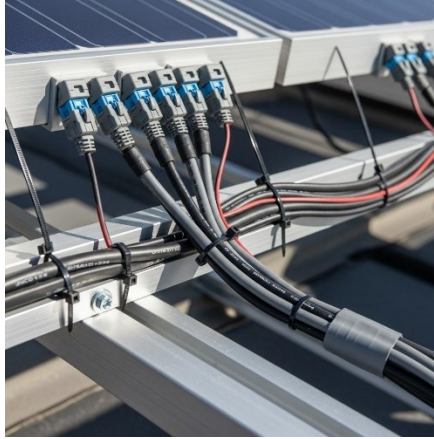
Figure 4.5 : Connecteurs et câbles CC
