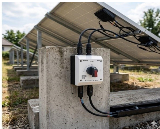
Figure 4.6 : Sectionneur CC
