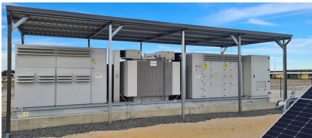
Figure 3.13 : Station d'onduleurs
